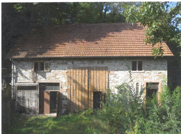
Blick auf die Scheune von Westen
