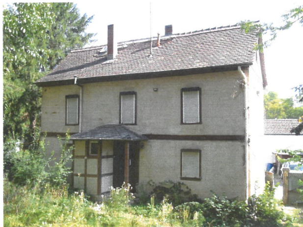
Wohnhaus (Vorderhaus) von Südwesten
