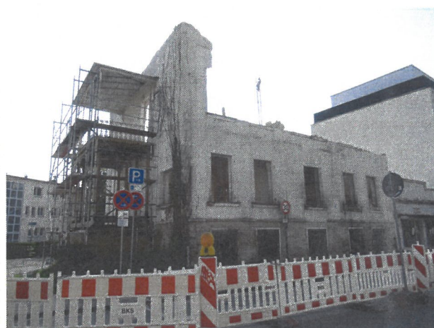
Abriss des Einzelkulturdenkmals „Zum Quellenpark 5“ (ca. 50 m entfernt)
