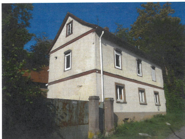
Wohnhaus (Vorderhaus) von Südosten
