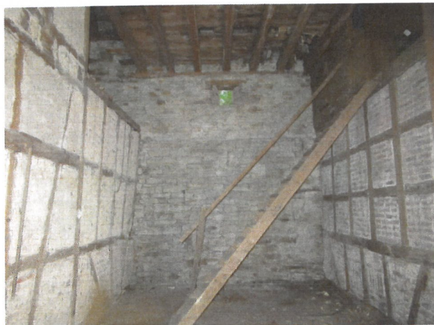
Blick in die Scheune (EG / Scheune)
