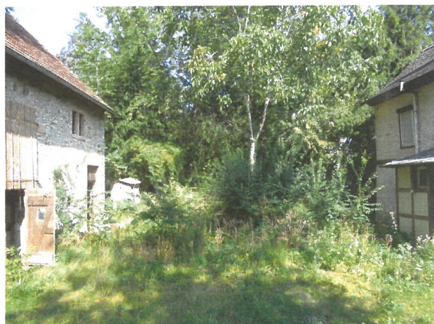
Blick zwischen die Gebäude (Blickrichtung = Nord)
