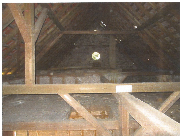
Blick in den Dachstuhl (DG / Scheune)
