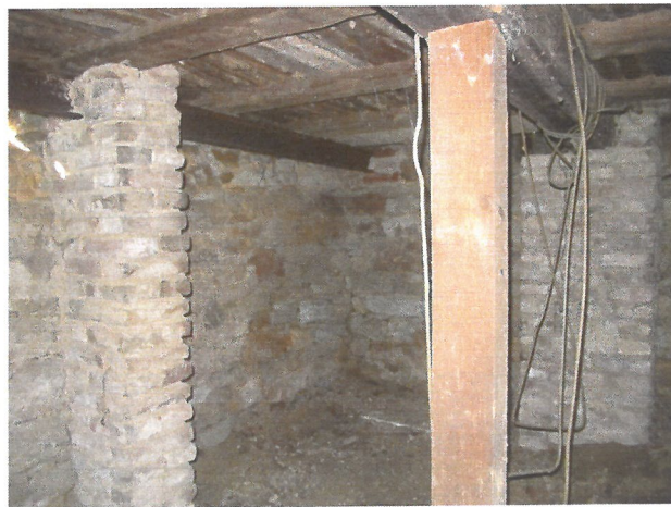
Teilunterkellerung mit erneuertem Stützpfeiler
