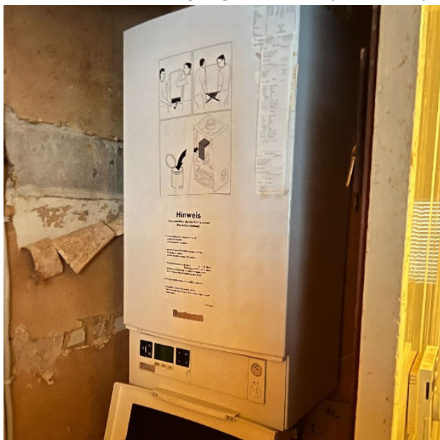
Gas-Brennwerttherme (11 KW, Einbau 2011). Warmwasser-Erzeugung dezentral (elektrisch).
