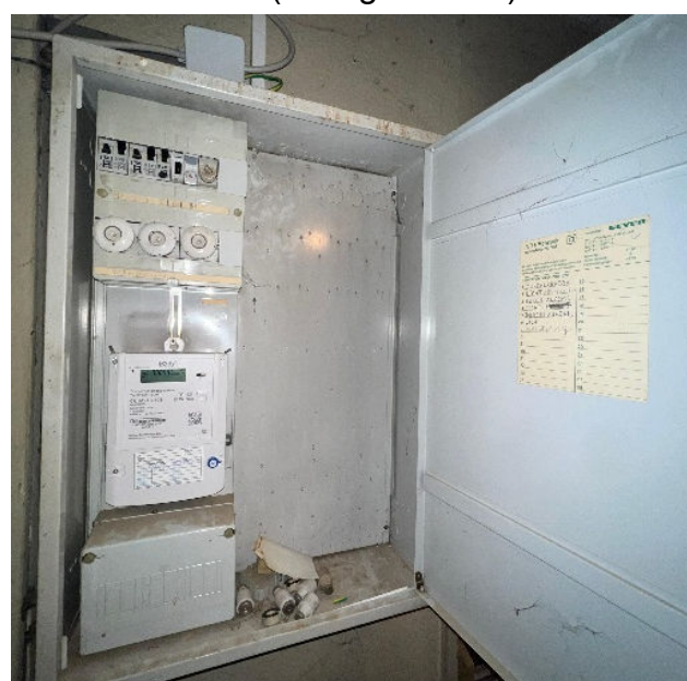
Elektro-Verteiler (Obergeschoss)
