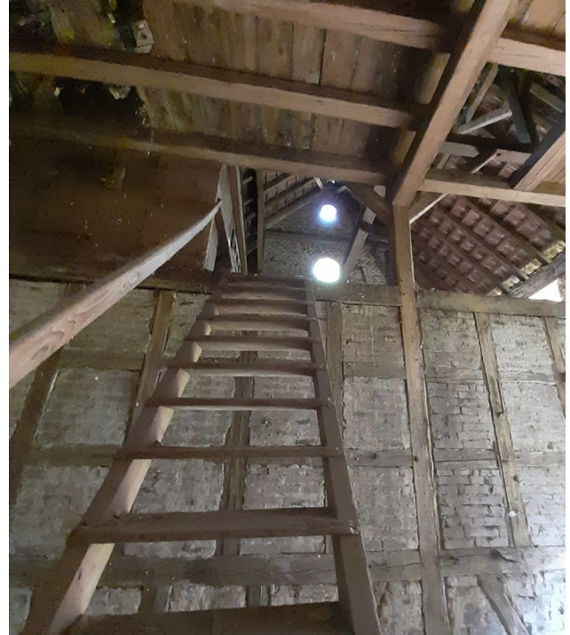
Blick aus Mittelzone in OG/Dachraum über Pferdestall (erkennbar Holzverschlag/Zimmer)
