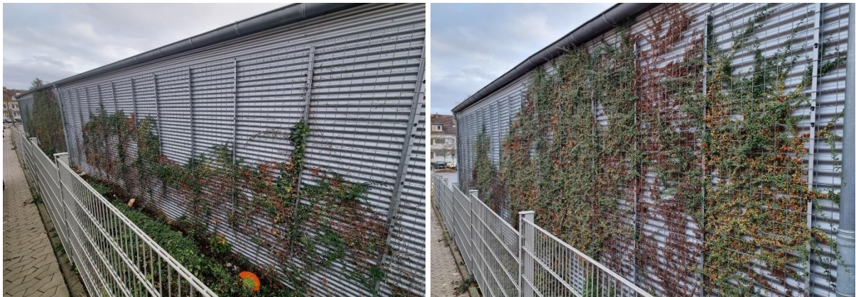
Abbildung 20: Fassadenbegrünung an der Westfassade des Lebensmittelvollsortimenters Quelle: Planergruppe ROB GmbH
