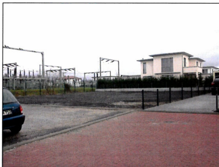
Abb.: Wasserdurchlässig befestigte Flächen südlich des Umspannwerkes
