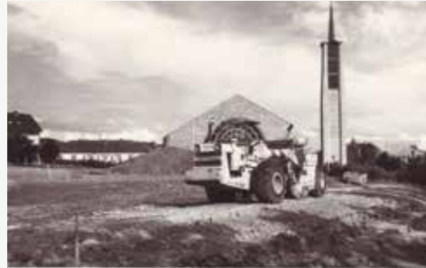
Erdgestaltungsarbeiten vor der Kirche St. Katharina
