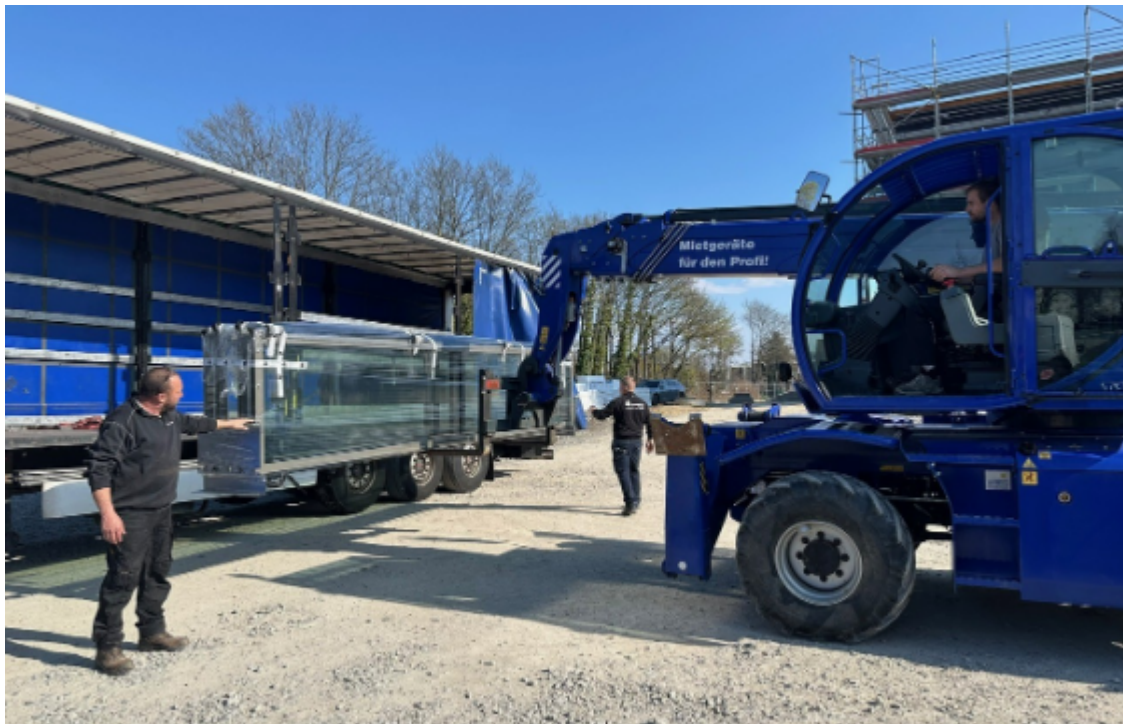
Anlieferung der tonnenschweren Tore. Foto: Stadt Bad Soden am Taunus
