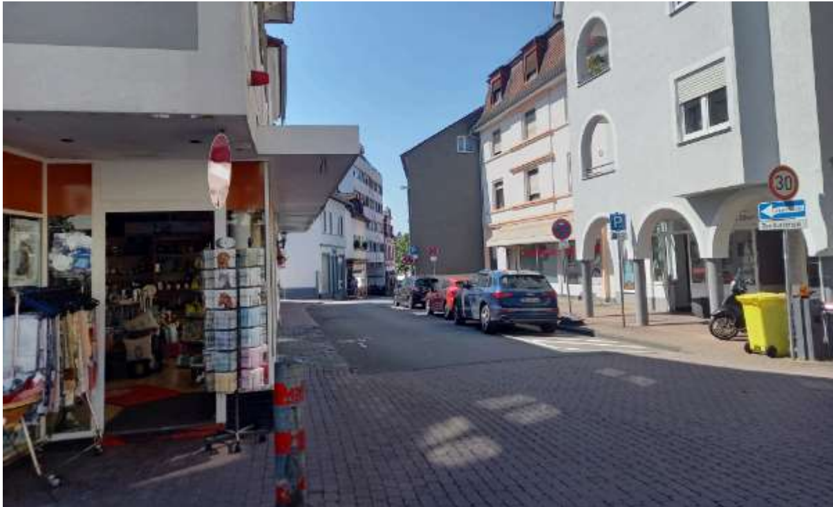
Die Straße Zum Quellenpark vor der umfangreichen Sanierung im Mai 2024. Fotos: Stadt Bad Soden am Taunus
