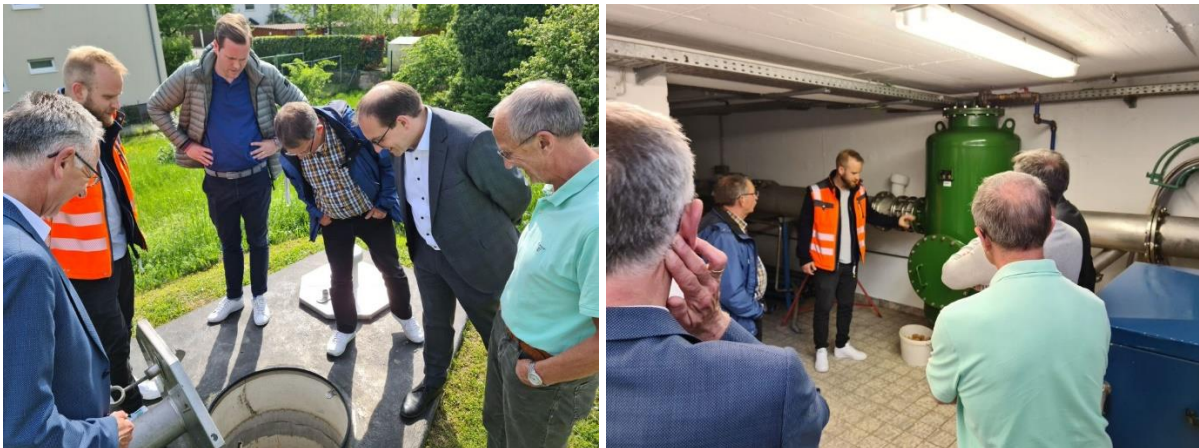
Bild 1: Ein Blick in den Tiefbrunnen 1 im Wasserwerk 1: Im Schacht geht es 3,5 Meter in die Tiefe, der Brunnen selbst hat eine Tiefenlage von ca. 35 Metern. Bild 2: In dem grünem Oxidator wird das Wasser gefiltert, bevor es das Wasserwerk verlässt.
