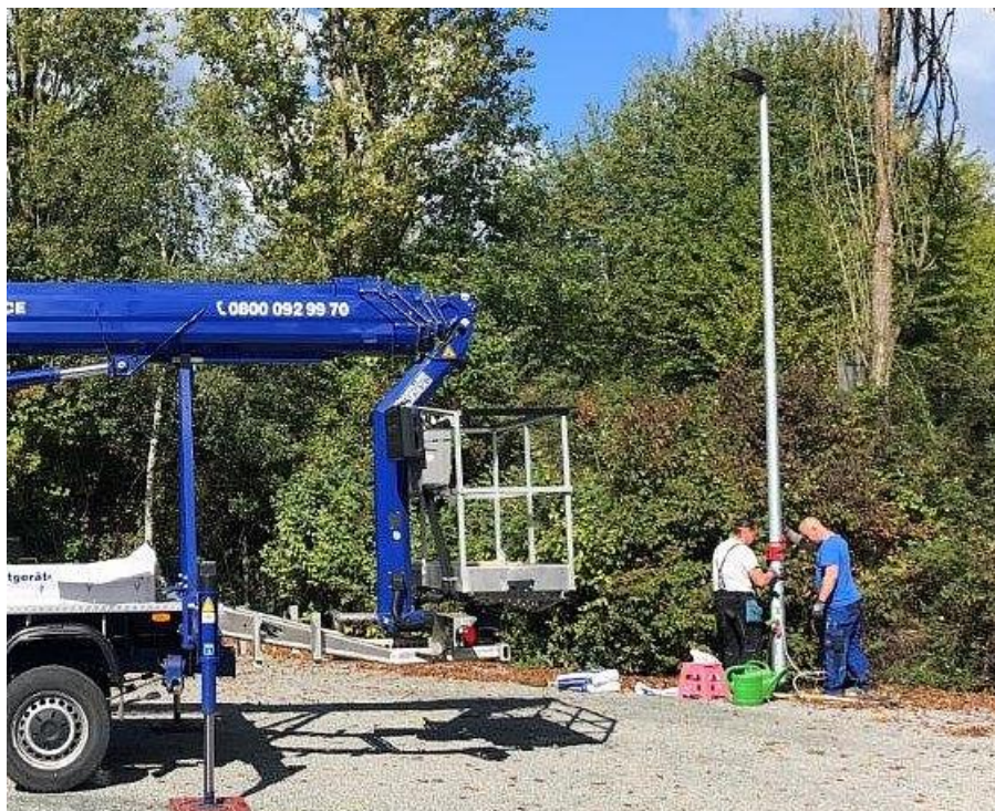
Installation der Beleuchtung auf dem neuen Schotterparkplatz. Foto: Stadt Bad Soden. Dieses Bild steht HIER in hoher Auflösung zum Download bereit.
