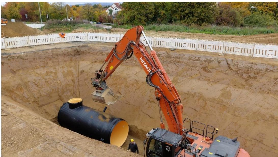
Derzeit werden die Rohre des Stauraumkanals mit einem Durchmesser von zwei Metern verlegt. Foto: Stadt Bad Soden am Taunus
