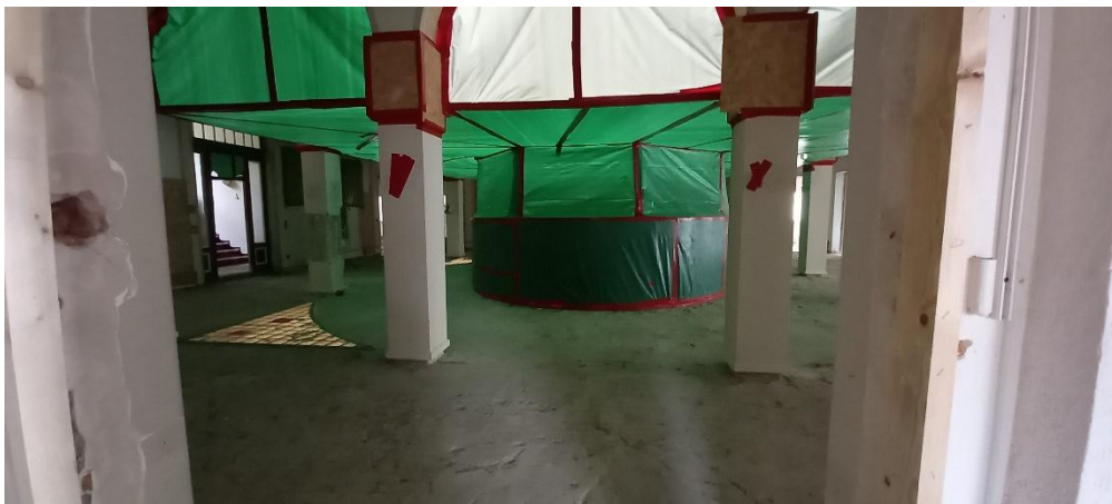
Die Schadstoffsanierung im zweiten Obergeschoss ist fast abgeschlossen. Foto: Stadt Bad Soden am Taunus Dieses Bild steht HIER zum Download bereit.
