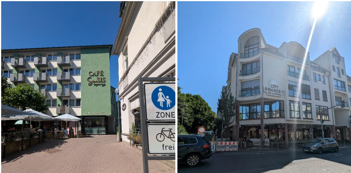
Abbildung 22: Südlich angrenzendes Wohnhaus mit Café im Erdgeschoss (links) und südöstlich angrenzende City-Arkaden (rechts) Quelle: Planergruppe ROB GmbH
