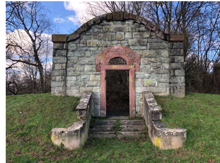
Aktueller Zustand der Treppenanlage
