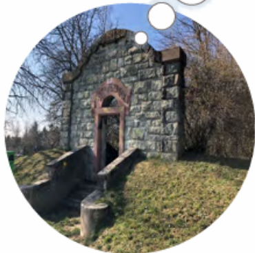
Altes Wasserwerk, Portal
