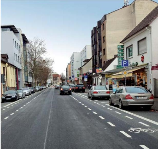
Abb. 50 Schutzstreifen für den Radverkehr (Dreieich)
