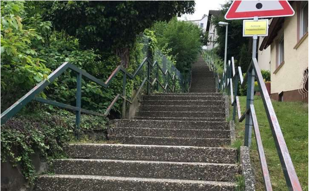
Abbildung 36: Treppenanlagen in der Langstraße in Altenhain (eigenes Foto)
