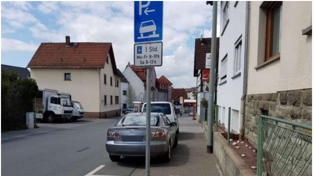
Abbildung 38: Erlaubtes Gehwegparken in der Schwabacher Straße (eigenes Foto)
