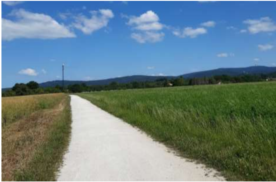
Abbildung 54: Ausgebauter Verbindungsweg zwischen Altenhain und Kelkheim
