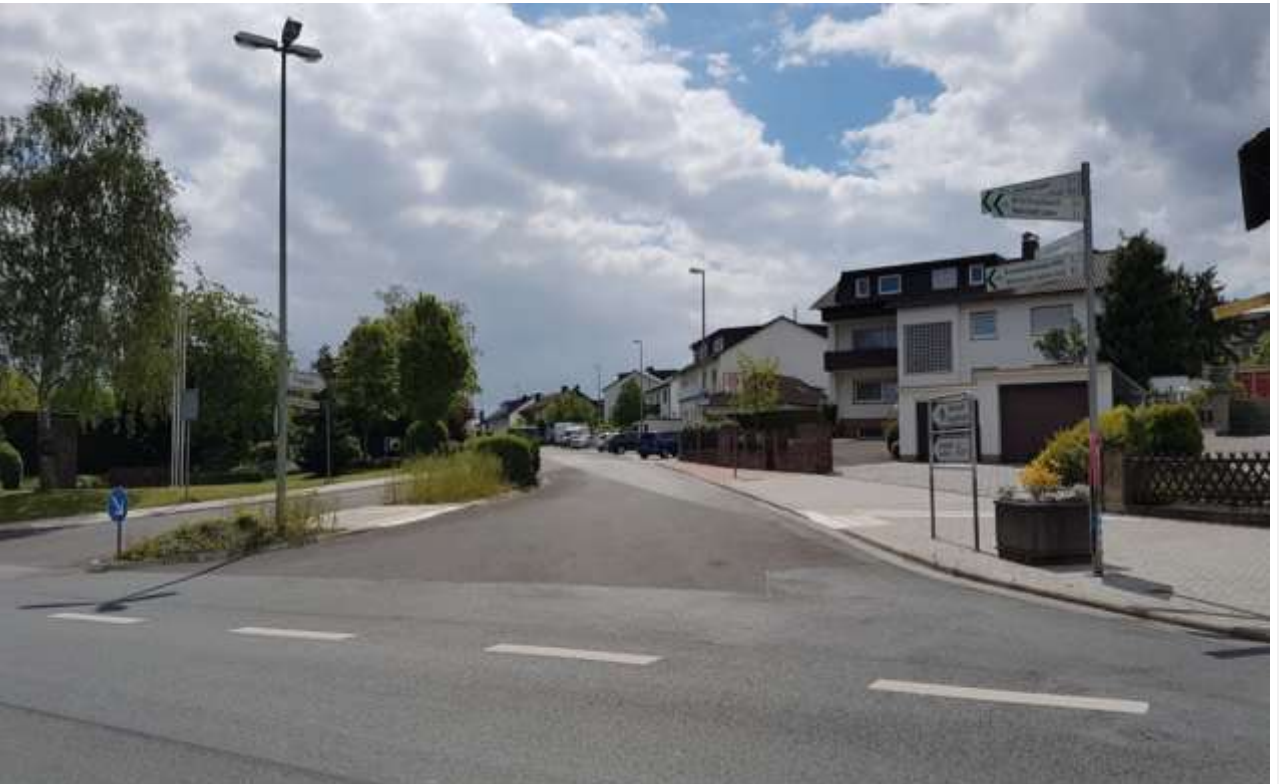
Abbildung 46: Einmündung mit weiten Radien Schwalbacher Straße / Rother Weingartenweg (eigenes Foto)
