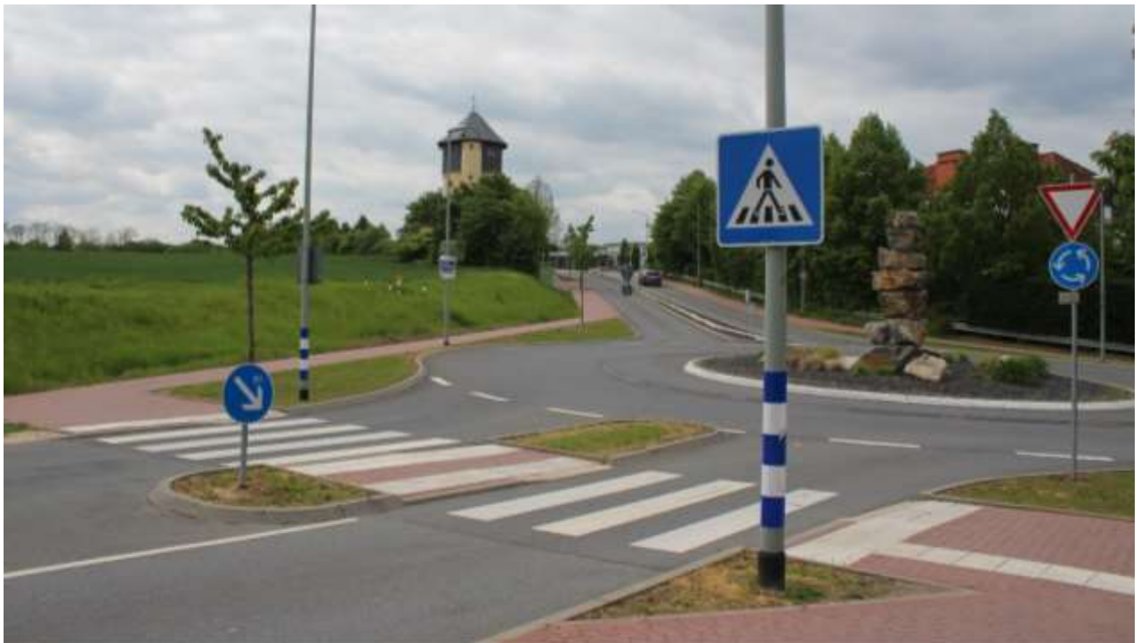
Abbildung 44: Beispiel Kreisverkehr in der Niederhofheimer Straße mit Fußgängerüberwegen (eigenes Foto)
