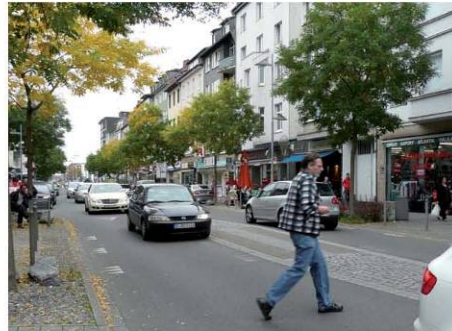
Abb. 60: Straßenbegleitende Mittelinsel als Querungshilfe, Kölner Straße, Dusseldorf
