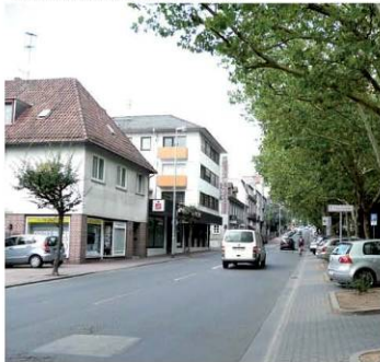
Abb. 59: Überbreite Fahrbahn Königsteiner Straße
